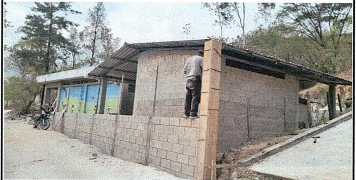
Foto 4: VISTA DE MEJORAMIENTO DE COCINA Y MURO PERIMETRAL.
